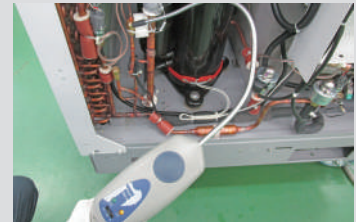
③冷媒漏れ調査
