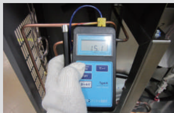
⑤冷媒配管温度測定
