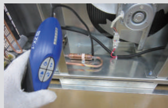
③冷媒漏れ調査
