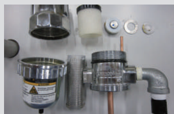
③ドレントラップの分解・清掃
