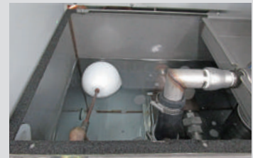
③水槽・Y型ストレーナの清掃
