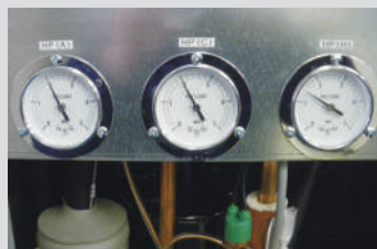
⑤冷媒圧力測定
