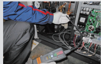
③冷媒漏れ調査
