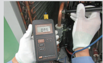
⑥冷媒配管温度測定
