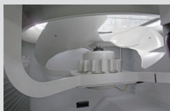
⑧モータ類の異常音確認
