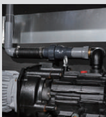
②空気配管の 漏れ・緩み確認
