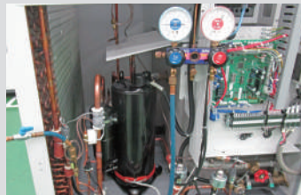
⑤冷媒圧力測定
