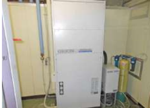
①設置状況の確認
