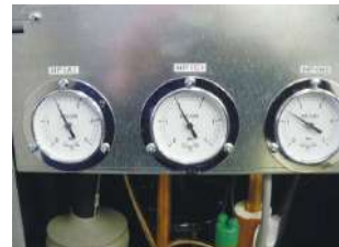
⑤冷媒圧力測定
