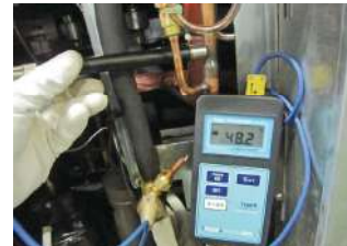
⑥冷媒配管温度測定
