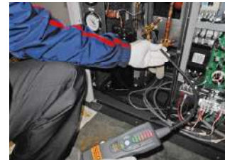
③ガス漏れ調査
