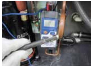
⑥冷媒配管温度測定
