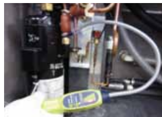
③ガス漏れ調査
