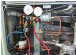
⑤冷媒圧力測定
