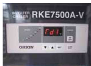
⑨モニターチェック
