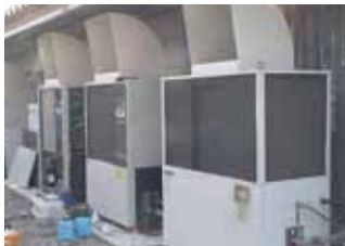
①設置状況の確認
