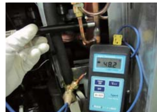
⑥冷媒配管温度測定
