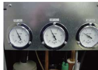
⑤冷媒圧力測定
