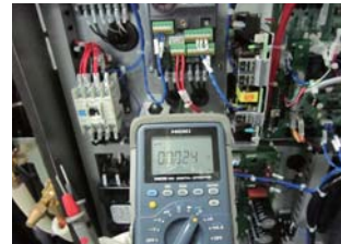
②インバータ静電容量測定
