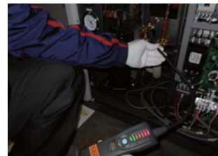
③ガス漏れ調査
