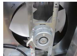
⑨モータ類の異常音確認
