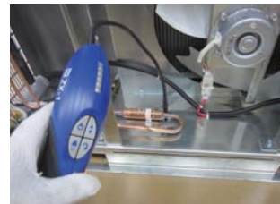
⑥ガス漏れ調査
