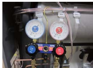
⑦冷媒圧力測定
