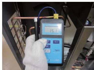
⑧冷媒配管温度測定
