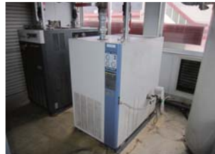
①設置状況の確認
