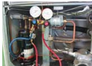
⑤冷媒圧力測定
