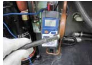
⑥冷媒配管温度測定
